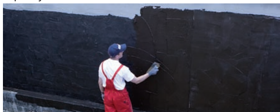
5. Nakładanie masy hydroizolacyjnej BOTAZIT® BM 92 Schnell/Winter
