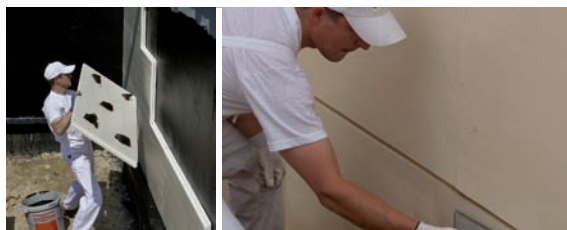
6. Klejenie płyt termoizolacyjnych URSA XPS
