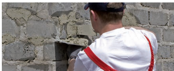
2. Uzupełnienie ubytków zaprawą BOTACEM® M 100
