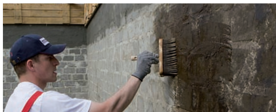
4. Gruntowanie podłoża środkiem BOTAZIT® BE 901
